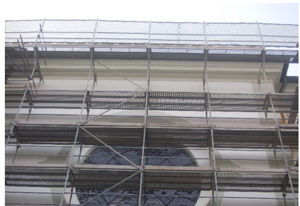
Gerüstbau für Mauersegler: 2,50-m-Freibereich unter der Dachtraufe
