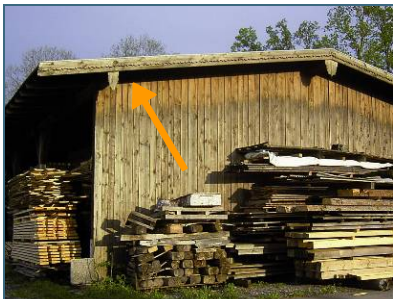
Abb. 2: Quartier von Rauhaufledermäusen im nur 2 cm breiten Spalt zwischen Windbrett und Balken.
