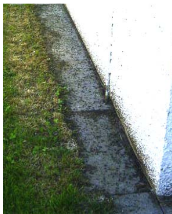
Abb. 6: Fledermausquartier unter der Holzverkleidung an der Flachdachkante (links) und Kotspuren am Boden unter den Hangplätzen (rechts)
