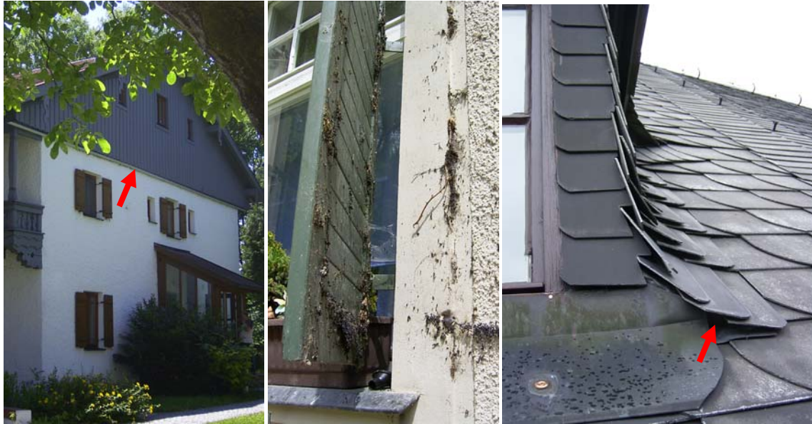
Abb. 15: Fledermausquartiere hinter Holzverkleidung und Fensterläden (links), Fensterläden (Mitte; der Laden wurde nach Abwanderung der Tiere geöffnet, um den Kot zu zeigen) und hinter einer Schindelverkleidung (rechts). Roter Pfeil: Einschlußöffnung
