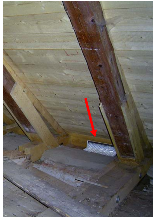
Abb. 29: Links: Einflugsmöglichkeit nach dem Umbiegen des Gitters (Pfeil). Der umgebogene Teil sollte dicht an dem dahinter befindlichen Gitter anliegen, damit sich die Tiere nicht im Spalt verfangen können (Maßangaben in mm). Rechts: Einflugsöffnung am Dachansatz (zwischen Dach und Mauer).
