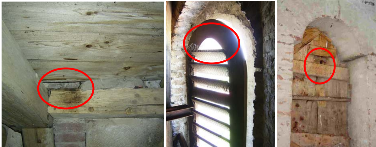
Abb. 12: Ausflugsöffnungen von Mausohrkolonien von innen gesehen (Öffnung bzw. Landeplatz vor der Öffnung durch Kreis markiert; man beachte den Kot und die braune Verfärbung des Holzes): Am Dachansatz (links; von außen läge die Öffnung hinter der Dachrinne), über der Vergitterung (Mitte) und in der Verbretterung einer Fensteröffnung (rechts).
