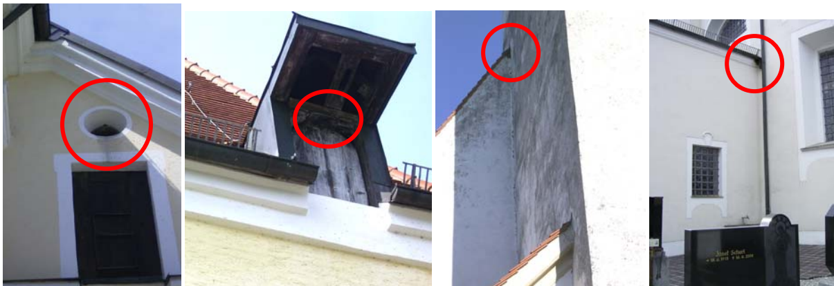
Abb. 13: Ausflugsöffnungen von Mausohrkolonien von außen gesehen (Öffnung durch Kreis markiert)
