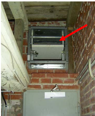
Abb. 25: Feuerschutzklappe als Fledermausdurchflug über der Tür.
