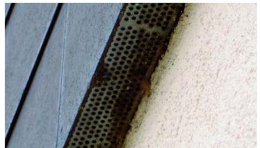
Abb. 27: Insektengitter an einem Flachdachabschluss.
